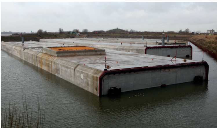
Figuur 1.1 / Het gina-profiel is ontworpen als een tijdelijke afdichting tijdens de bouw; links te zien als zwarte rand rond de kopskant van het tunnelelement. Tijdens het koppelen van de elementen wordt dit profiel samengedrukt. Aan de binnenzijde van de voeg wordt een omegaprofiel aangebracht als definitieve afdichting. (Foto: beeldbank Rijkswaterstaat/FotoMix)
