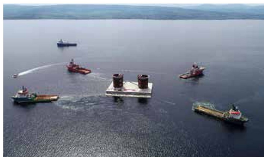
Vier sleepboten om de caisson te positioneren.
